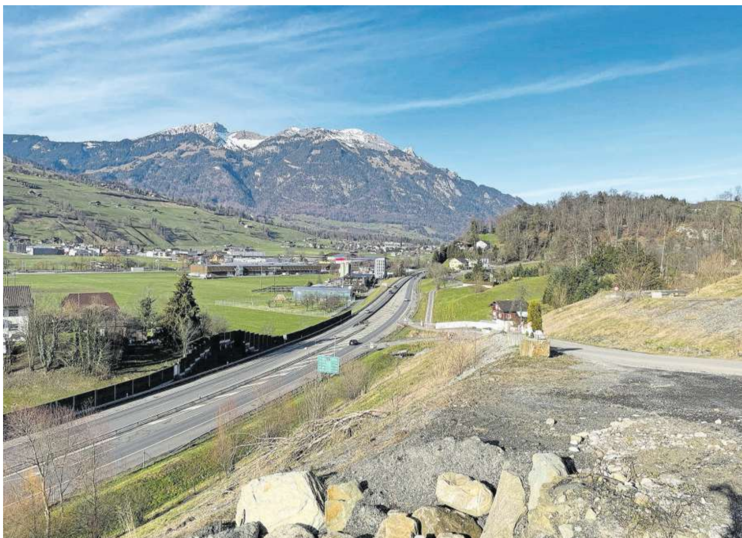
In diesem Bereich der A8 könnte dereinst ein Halbinschluss entstehen.
